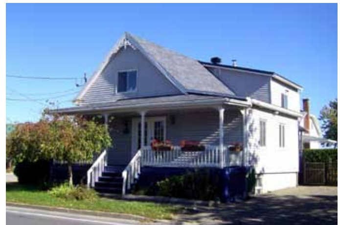
Fig. 4.2.3. Maison revêtue de clin et coiffée d'un toit recouvert de bardeaux d'asphalte, située au 13 530, avenue de l'Église.
