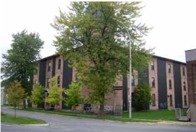
Fig. 2.2.5. Bâtiment industriel implanté en bordure de la voie publique, sis au 1700, boulevard Laframboise.
