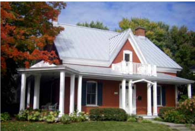
Fig. E.04. Exemple de cottage dont la composition de la façade est symétrique, à l'exception de la galerie, visible au 3120, rue Girouard Ouest.
