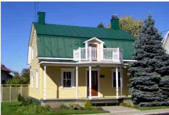
Fig. 4.1.4. Maison revêtue de clin et coiffée d'un toit mansardé recouvert de tôle, sise au 5180, rue des Seigneurs Est.
