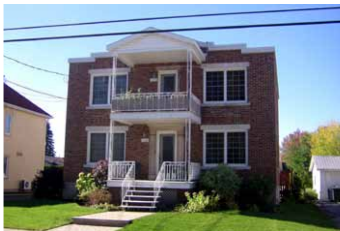
Fig. 4.5.3. Duplex à toit plat avec galerie et balcon superposés et auvent à fronton, sis au 14 245, avenue Guy.
