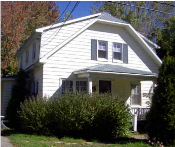
Fig. 4.4.4. Résidence avec galerie couverte, extensions de toit et fenêtres à guillemets simples et jumelées, située au 13 630, avenue Rachel-Turgeon.
