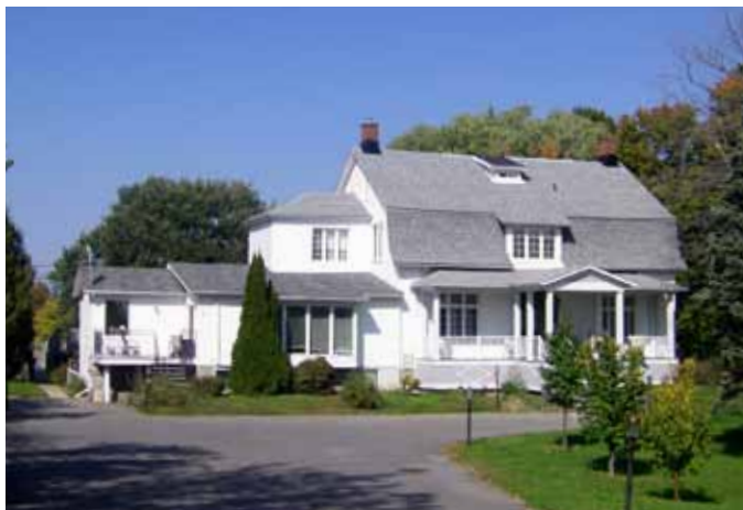
Fig. 3.3.3. Maison revêtue d'un parement léger avec un toit recouvert de bardeau d'asphalte, visible au 3160, rue Saint-Pierre Ouest.
