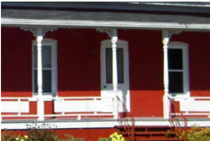
Fig. B.04. Ouvertures à arc surbaissé et fenêtres à guillotine, observables au 5630, rue des Seigneurs Est.
