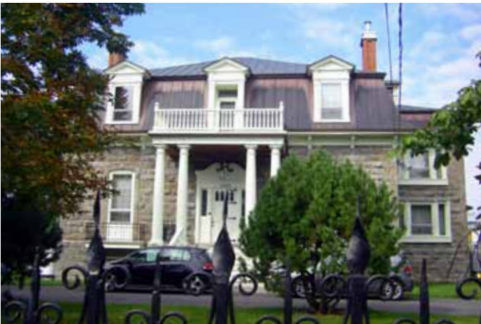
Fig. 3.1.4. Bâtiment possédant galerie et balcon superposés, colonnes, lucarnes et cheminées, situé au 2400, rue Saint-Pierre Ouest.
