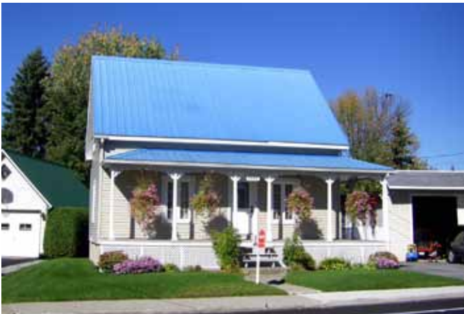
Fig. 4.1.6. Cottage avec toit à versants droits, visible au 5200, rue des Seigneurs Est.
