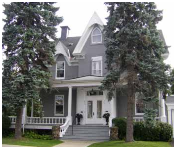
Fig. D.07. Résidence dotée d'ouvertures aux formes variées, visible au 2715, rue Girouard Ouest.
