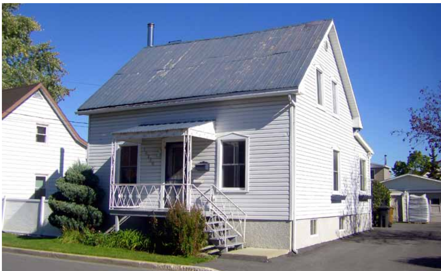
Fig. E.01. Cottage avec toit à versants droits, visible au 14 270, avenue Guy.
