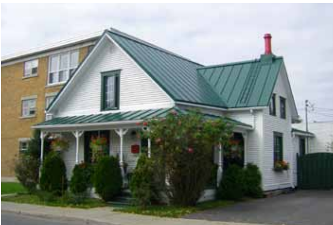
Fig. E.08. Variante 1 : Cottage avec mur-pignon en façade, également avec pignon perpendiculaire (variante 3), visible au 2850, rue Girouard Ouest.
