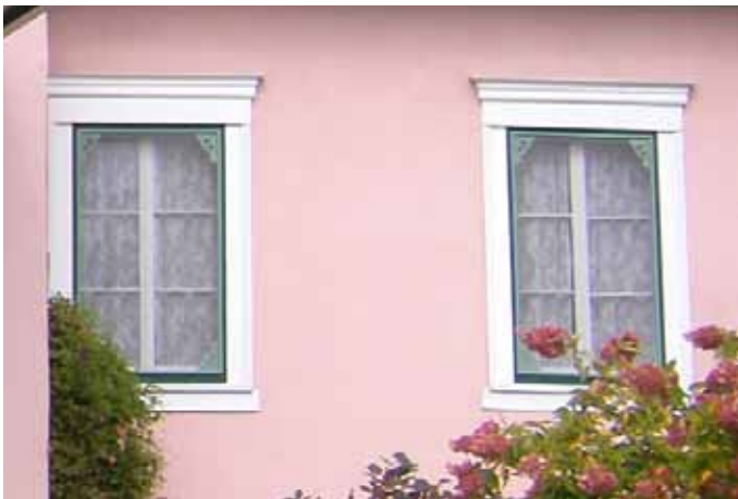
Fig. A.05. Fenêtres à battants à six carreaux, observables au 2210, rue Saint-Pierre Ouest.
