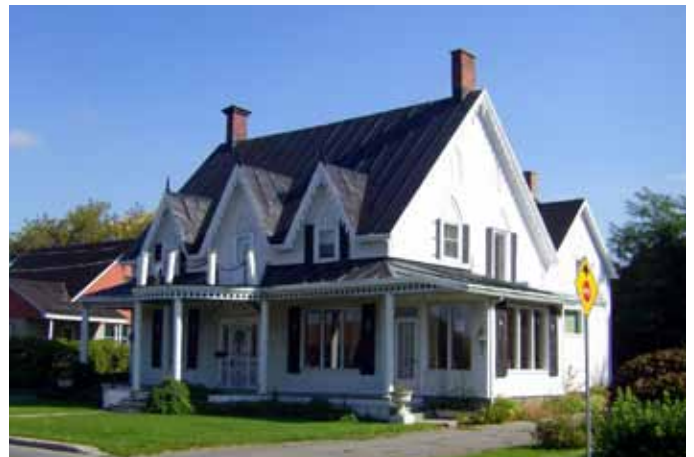
Fig. D.05. Résidence revêtue de clin de bois avec un toit recouvert de tôle, sise au 2875, rue Saint-Pierre Ouest.
