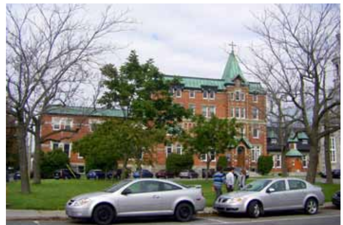
Fig. 1.1.6. Immeuble implanté en retrait de la rue, avec parterre aménagé et terrain de stationnement, sis au 2250, rue Girouard Ouest.
