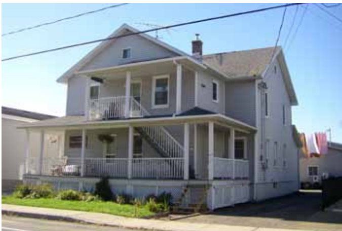
Fig. 4.2.4. Résidence avec galerie couverte et fenêtres à guillotine, sise au 13 665-13 685, avenue de l'Église.
