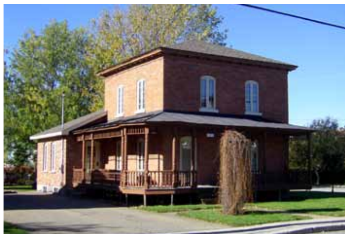
Fig. G.02. Maison cubique avec galerie courant sur deux façades et annexe latérale, observable au 13 555, avenue de l'Église.
