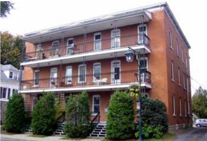
Fig. C.09. Variante 4 : Multiplex visible au 2928-2944, rue Girouard Ouest.
