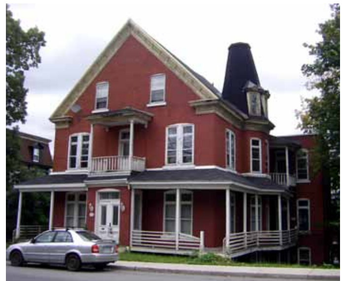
Fig. 2.3.6. Résidence à l'architecture éclectique, visible au 730, rue Girouard Ouest.
