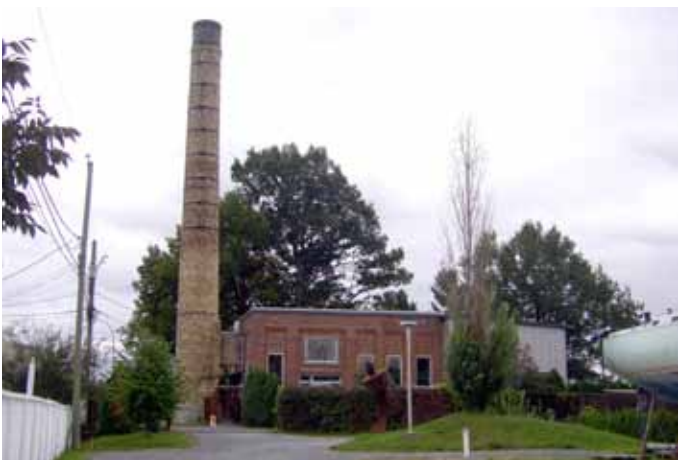
Fig. J.03. Ancienne chaufferie de la Goodyear Cotton, située au 1095, rue Delorme, dans l'unité de paysage 2.2 Industries .
