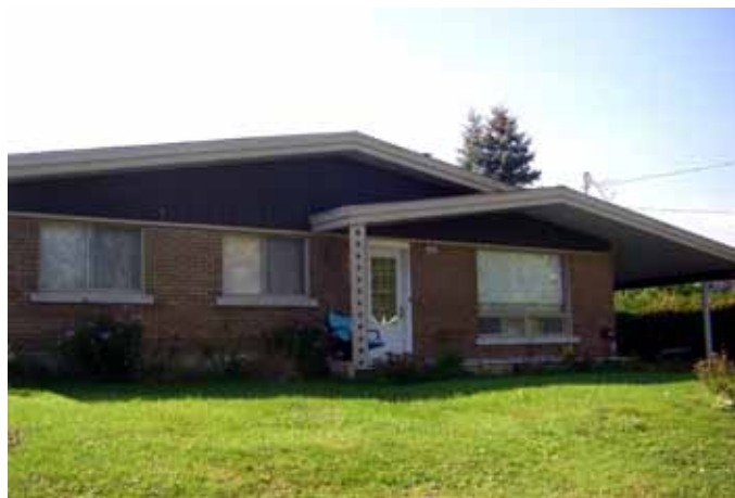
Fig. H.03. Bungalow de plan rectangulaire avec toit à faibles pentes accentuant son horizontalité, sis au 15 345, avenue Gingras.
