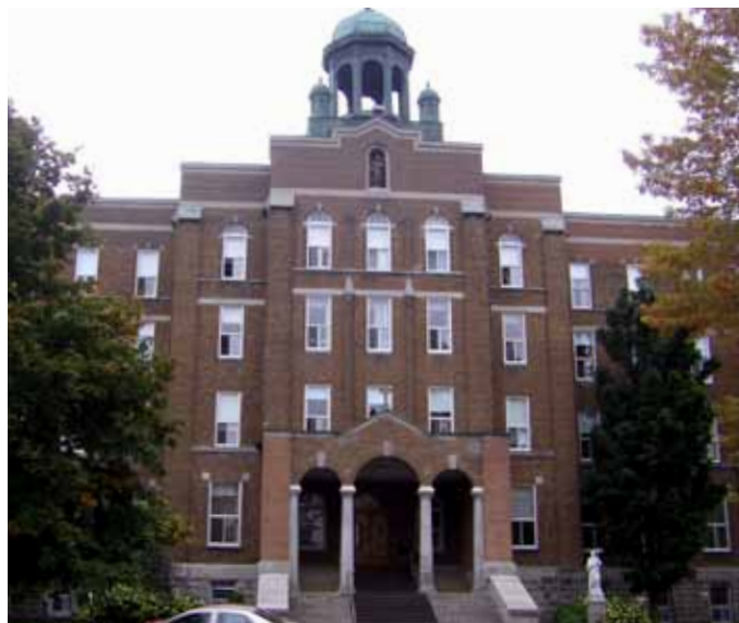
Fig. 1.1.2. Immeuble institutionnel de grandes dimensions avec toit plat, situé au 805, avenue Raymond.
