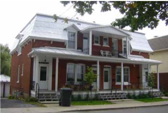
Fig. B.07. Variantes 3 et 5 : Duplex à mansarde jumelée et avec toit plat à brisis, visible au 2361-2367, rue Girouard Ouest.
