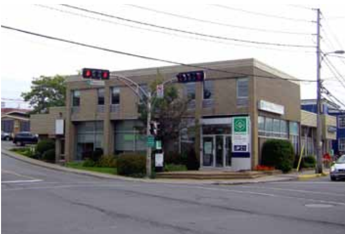
Fig. K.04. Immeuble de services bancaires situé au 2055-2095, rue Saint-Pierre Ouest, dans l'unité de paysage 3.1 Précieux-Sang .
