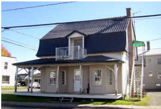
Fig. B.06. Variantes 2 et 4 : Duplex à mansarde, également avec toit à deux versants mansardés, observable au 5075-5095, rue des Seigneurs Est.
