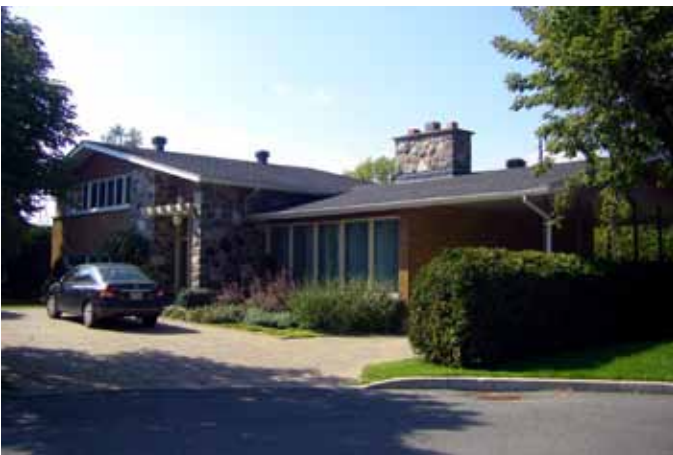
Fig. 3.2.4. Résidence avec large fenestration horizontale et dont le perron et l'espace de stationnement sont protégés par le toit à faibles pentes, située au 15 325, avenue Gingras.
