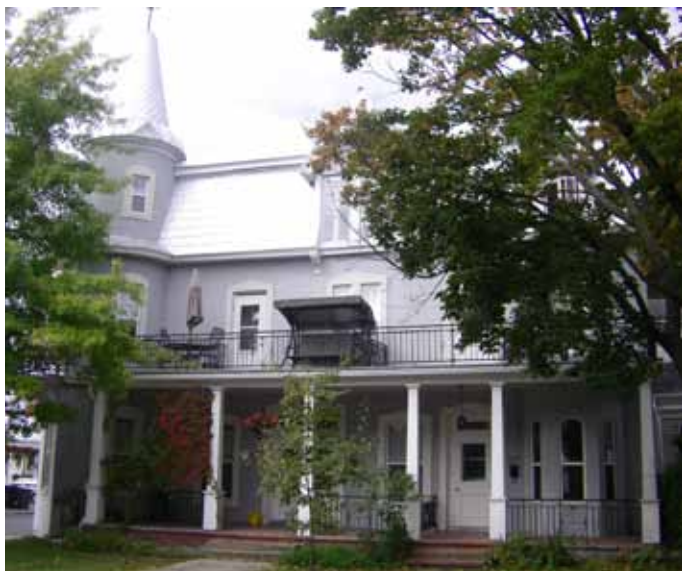
Fig. D.06. Résidence dont la composition architecturale est asymétrique et les ouvertures irrégulières, observable au 2680-2690, rue Girouard Ouest.
