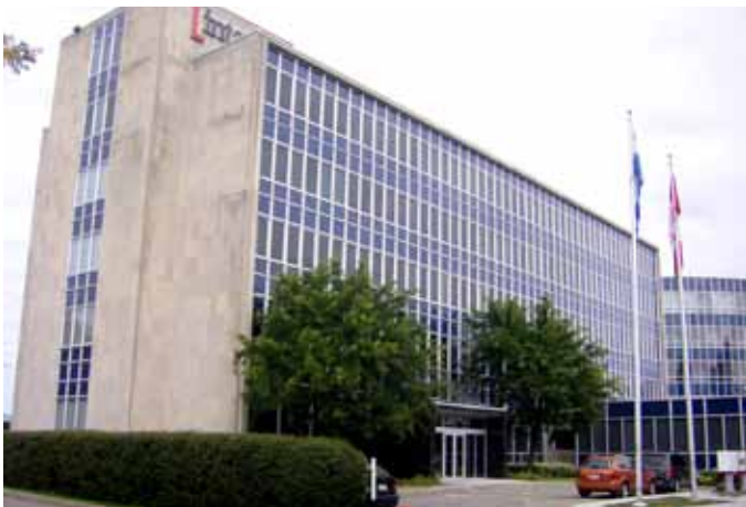
Fig. 1.1.3. Immeuble commercial revêtu en grande partie de verre, sis au 2450, rue Girouard Ouest.
