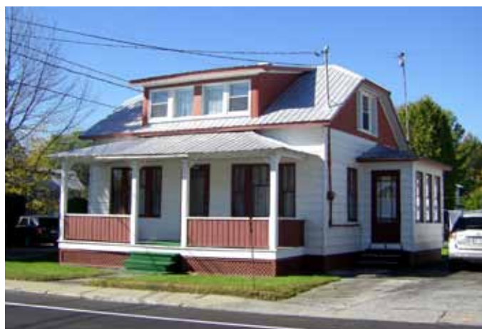
Fig. F.03. Bâtiment dont seul le petit volume secondaire brise la composition symétrique, observable au 5410, rue des Seigneurs Est.
