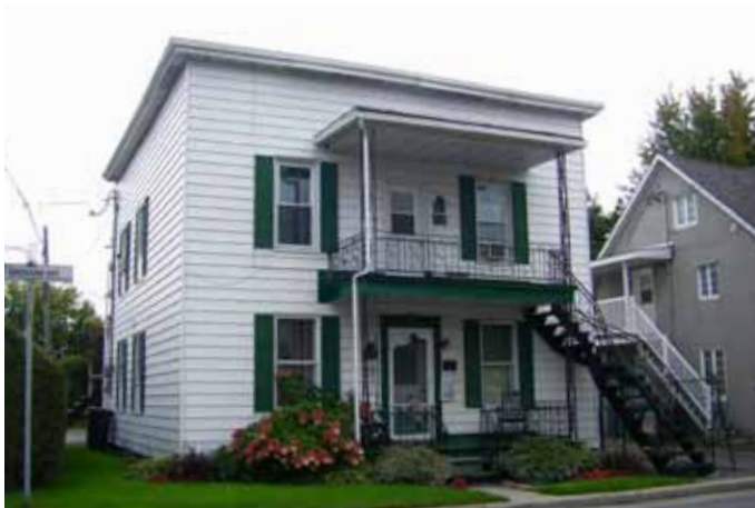
Fig. C.06. Variante 1 : Duplex avec escalier extérieur, visible au 931-935, rue Girouard Est.
