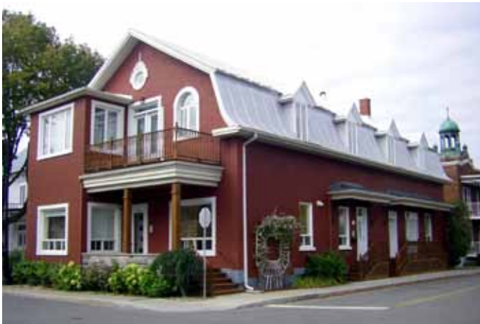
Fig. 1.2.3. Bâtiment résidentiel revêtu de brique et d'un toit en tôle à baguettes, sis aux 2300, rue Girouard Ouest et 705, avenue Raymond.
