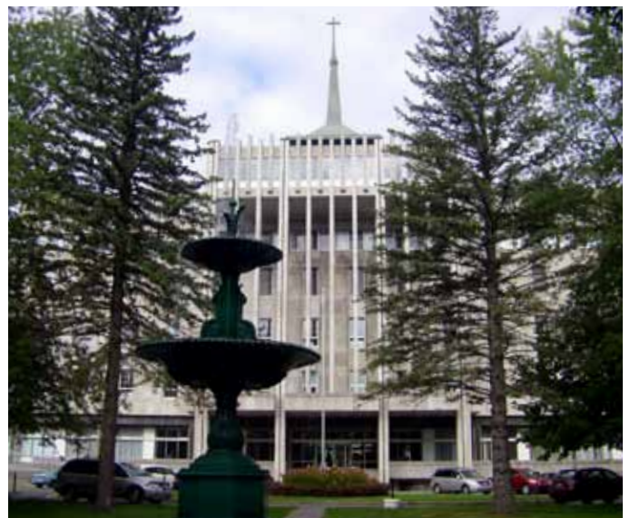
Fig. 2.1.5. Bâtiment institutionnel, situé au 650, rue Girouard Est.
