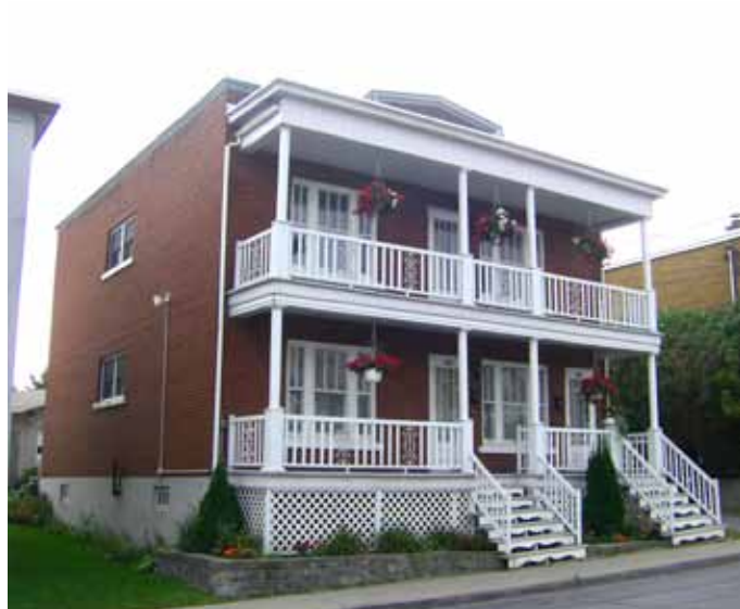
Fig. 3.1.2. Résidence de deux étages avec toit plat, située au 2145, rue Saint-Pierre Ouest.
