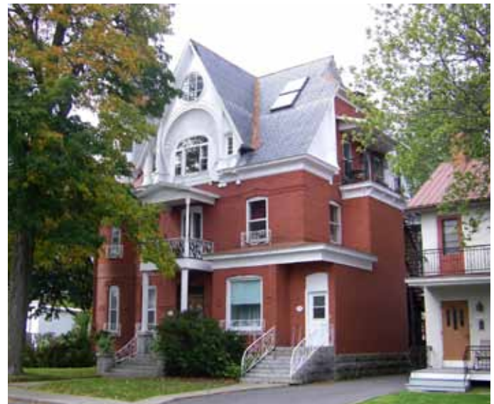
Fig. D.11. Variante 3 : Duplex éclectique, visible au 2780-2790, rue Girouard Ouest.
