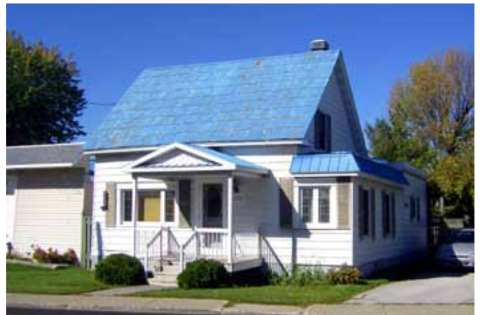
Fig. E.05. Exemple de cottage dont la composition de la façade est asymétrique, observable au 5220, rue des Seigneurs Est.
