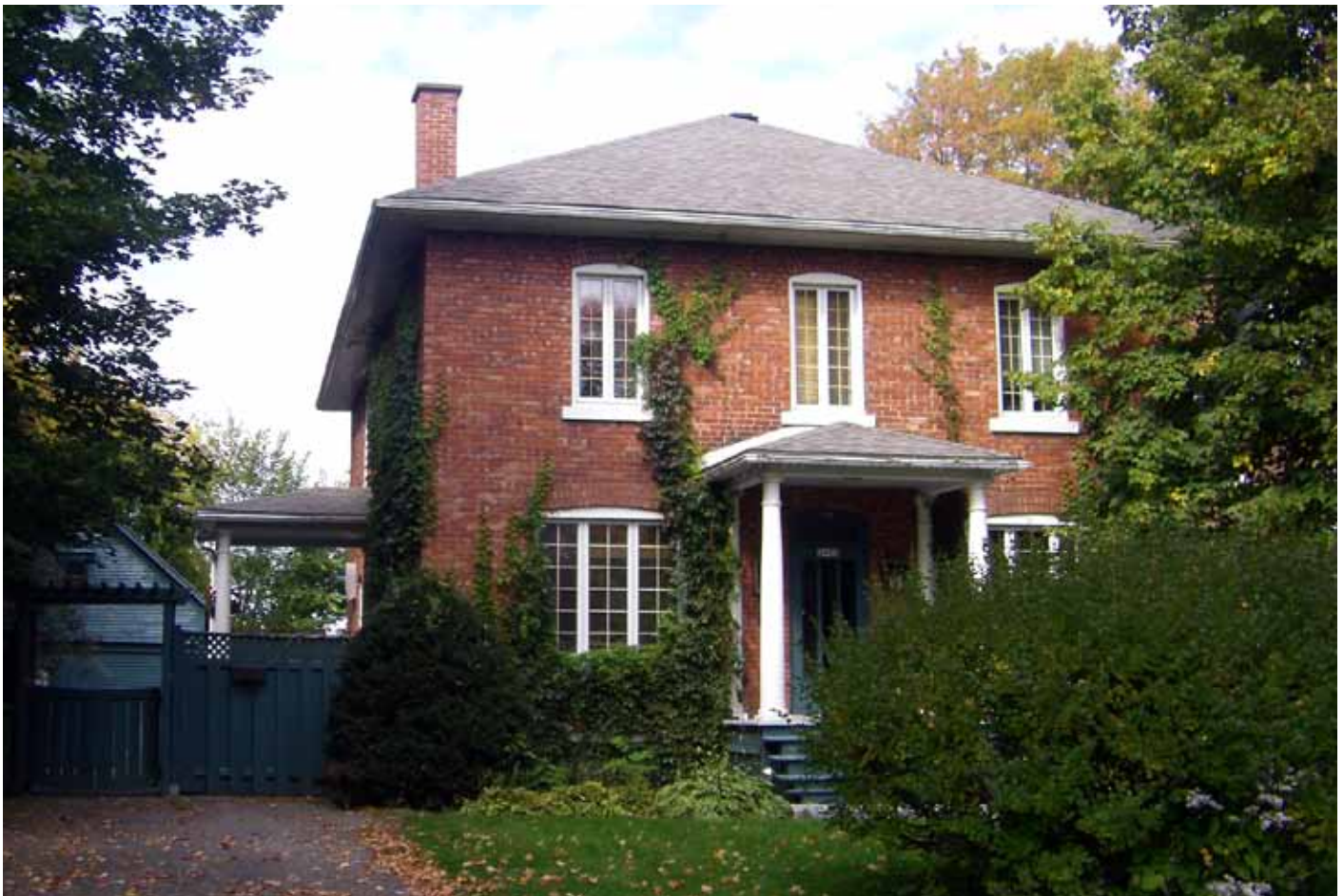
Fig. G.01. Modèle de base de la maison avec toit à pavillon, visible au 2450, rue Saint-Pierre Ouest.
