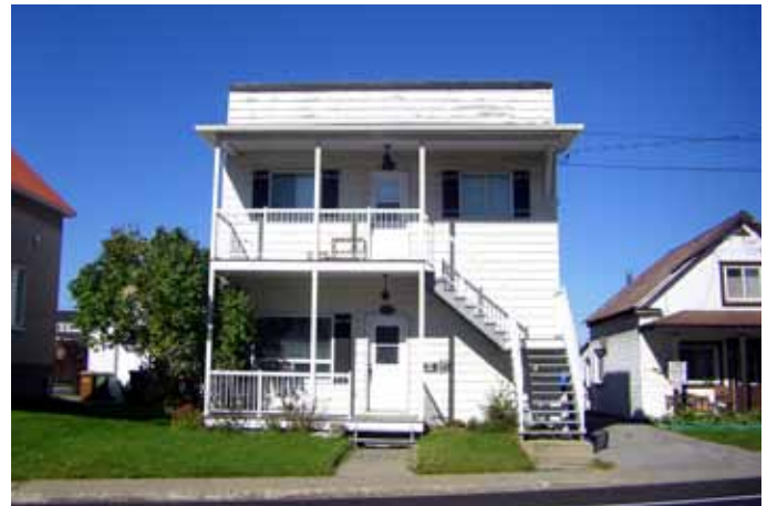
Fig. 4.1.7. Implantation typique des résidences situées sur la rue des Seigneurs Est, comme l'illustre le 5130, rue des Seigneurs Est.
