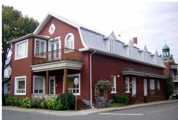
Fig. B.02. Maison à mansarde avec parement de brique et toit recouvert de tôle à baguettes, située au 2300, rue Girouard Ouest.
