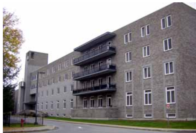
Fig. 2.1.3. Immeuble revêtu de pierre et de brique, situé au 650, rue Girouard Ouest.
