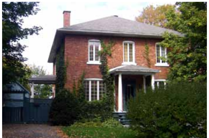
Fig. 3.1.3. Maison cubique revêtue de brique et coiffée d'un toit recouvert de bardeaux d'asphalte, visible au 2450, rue Saint-Pierre Ouest.
