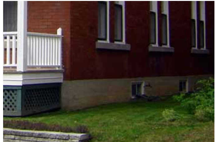
Fig. C.03. Soubassement en béton et parement de brique, observables au 2912-2920, rue Girouard Ouest.
