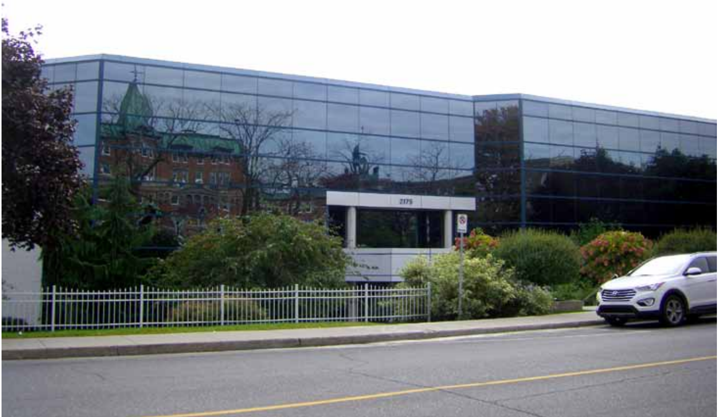
Fig. K.01. Immeuble de bureaux visible au 2175, rue Girouard Ouest, dans l'unité de paysage 1.1 Noyau institutionnel .
