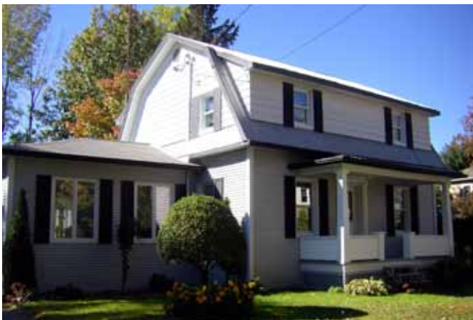
Fig. 4.4.2. Maison à mansarde avec extensions de toit, galerie couverte et annexe latérale, située au 13 635, avenue Rachel-Turgeon.
