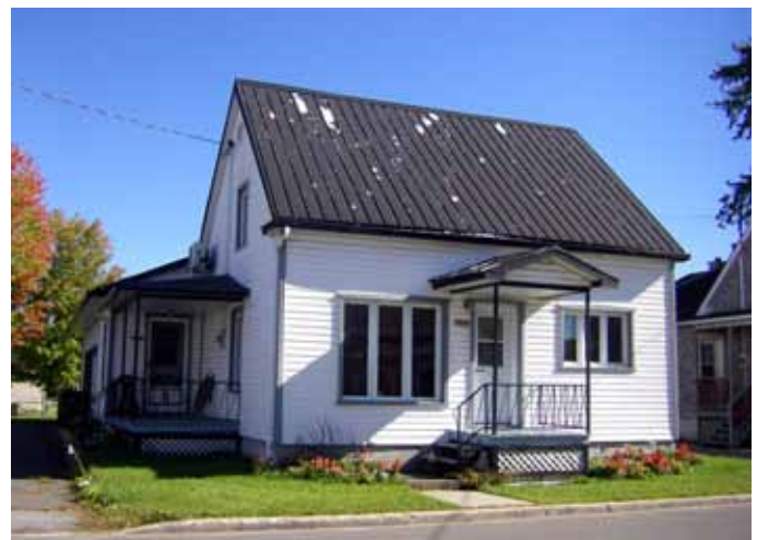
Fig. 4.5.7. Implantation typique des maisons avec toit à deux versants de l'avenue Guy, tel qu'illustrée au 14 210, avenue Guy.
