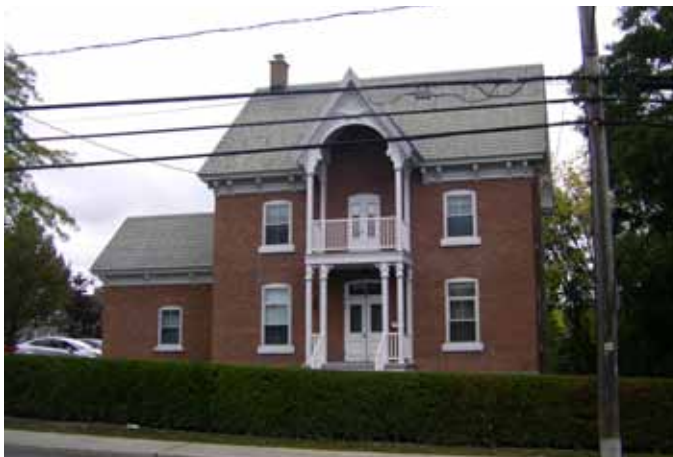
Fig. 2.3.2. Cottage de deux étages et demi avec toit à versants et annexe latérale, visible au 590, rue Girouard Ouest.
