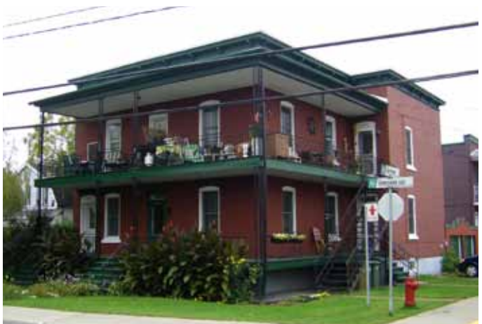
Fig. C.07. Variante 2 : Duplex avec plus de deux logements, visible au 980-990, rue Girouard Est.
