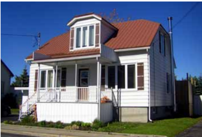
Fig. 4.3.6. Implantation des maisons avec toit à demi-croupes situées sur le côté nord de la rue Marquette, comme en témoigne le 5220, rue Marquette.
