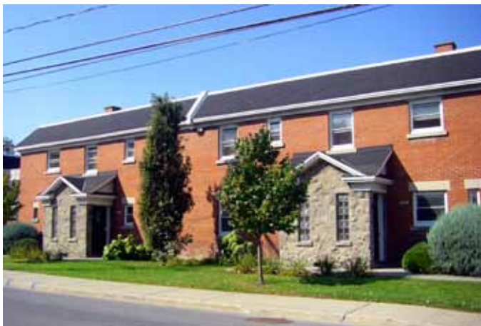
Fig. 3.2.3. Maisons en rangée revêtues de brique avec portiques revêtus de pierre, visibles au 2850-2880, rue Saint-Pierre Ouest.
