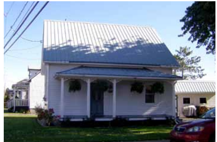
Fig. 4.3.3. Maison revêtue de clin de vinyle et coiffée d'un toit recouvert de tôle, sise au 14 020, avenue Guy.
