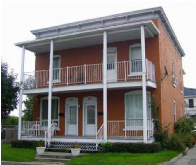
Fig. 2.4.4. Habitation avec galerie et balcon superposés et corniche à consoles, située au 961, rue Girouard Est.
