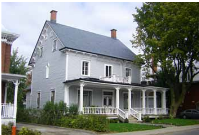
Fig. E.02. Cottage de deux étages et demi avec large galerie couverte, cheminées et annexe arrière, situé au 2310, rue Girouard Ouest.
