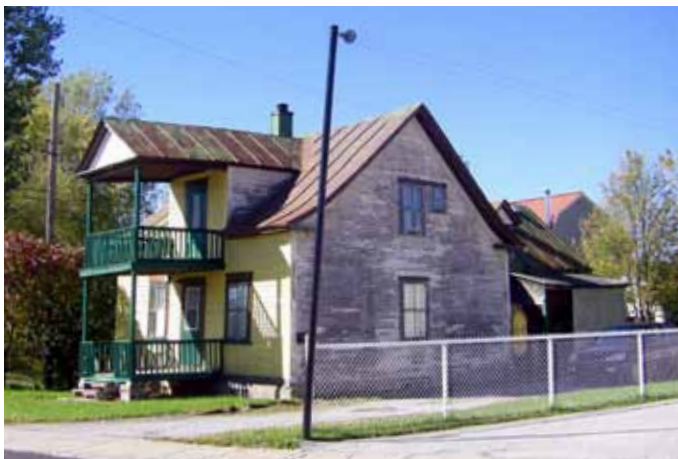
Fig. A.03. Maison avec parement de bois et toit recouvert de tôle à baguettes, située au 5600, rue des Seigneurs Est.
