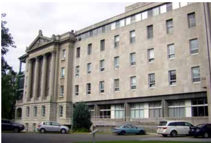
Fig. 2.1.2. Immeuble de cinq étages à toit plat, visible au 650, rue Girouard Est.
