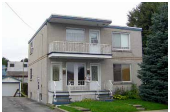
Fig. 2.4.5. Duplex à toit plat, sis au 1645, avenue Aristide.
