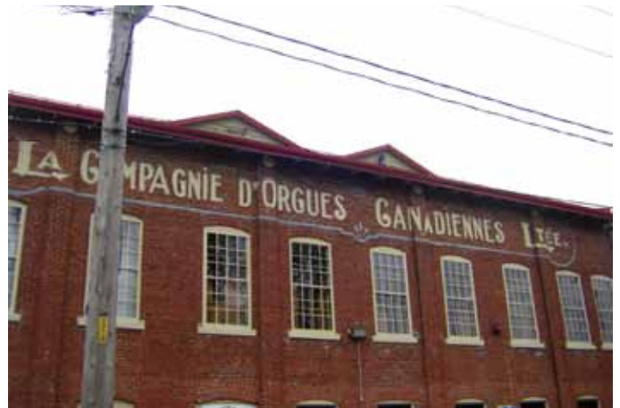
Fig. 2.2.4. Alignement d'ouvertures de fenêtres à arc surbaissé et pilastres de brique, observables au 1500, boulevard Laframboise.
