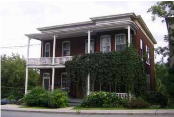
Fig. C.02. Duplex avec avancée, galerie et balcon superposés et auvent plat, situé au 545-555, rue Girouard Ouest.
