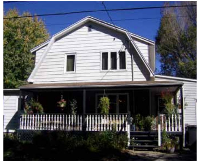
Fig. 4.4.5. Maison à toit mansardé, sise au 13 590, avenue Rachel-Turgeon.
