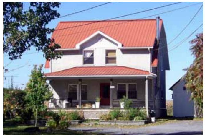
Fig. 4.1.5. Résidence avec galerie couverte et fenêtres à guillotine simples et jumelées, située au 5570, rue des Seigneurs Est.
