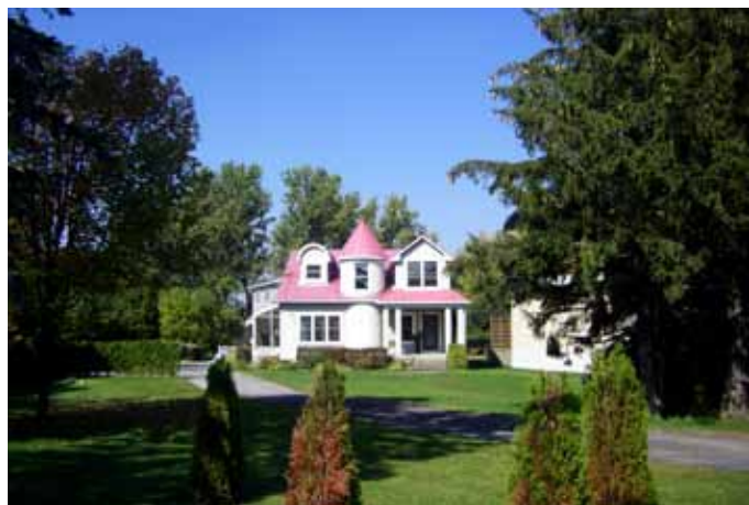
Fig. D.02. Exemple d'implantation d'une villa en milieu de villégiature, tel qu'illustré par le 3550, rue Saint-Pierre Ouest.
