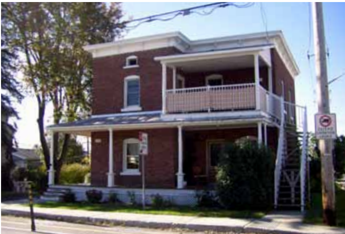
Fig. 4.2.6. Duplex à toit plat, sis au 13 715-13 725, avenue de l'Église.
