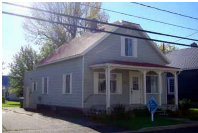
Fig. F.06. Variante 1 : Maison avec demi-croupe en façade avant, située au 5225, rue Marquette.
