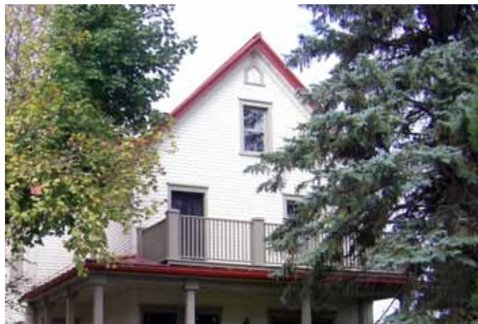
Fig. E.07. Encadrements d'ouvertures, bordure de toit, auvent et balustrade peints de couleurs contrastantes, observables au 2300, rue Saint-Pierre Ouest.
