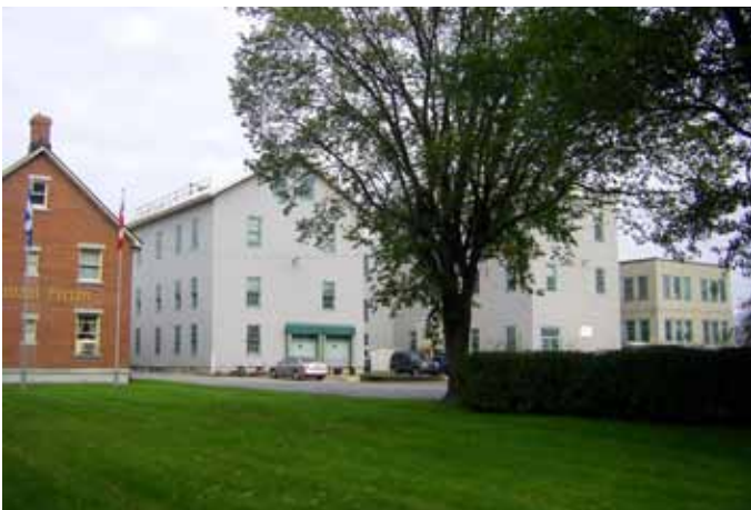
Fig. 2.4.6. Ensemble de bâtiments industriels, visible au 900, rue Girouard Est.
