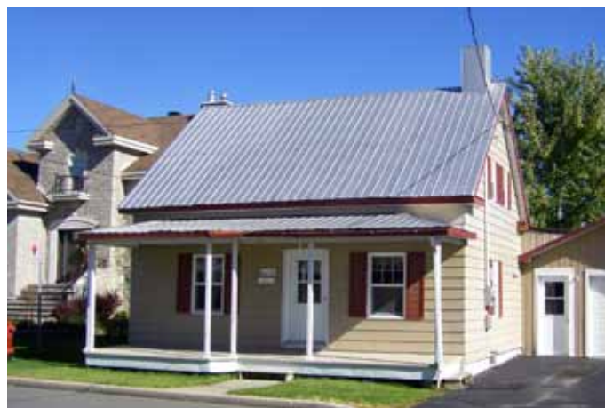
Fig. 4.5.2. Maison avec toit à deux versants, large galerie couverte et volume annexe, située au 14 320, avenue Guy.
