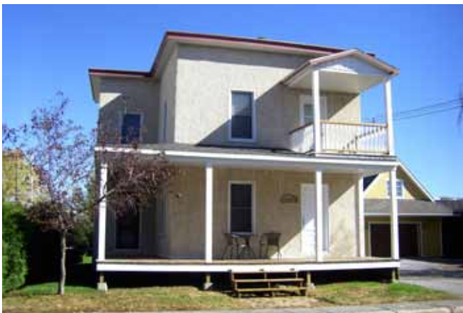
Fig. 4.5.4. Bâtiment avec parement de crépi, situé au 14 200, avenue Lambert-Grenier.
