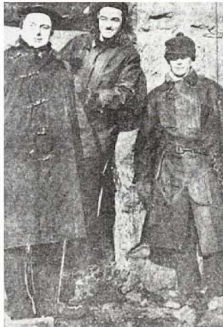
Les flammes sont sous contrôle. Après avoir travaillé durant des heures sans repos pour éteindre l'incendie et sauver des enfants, trois pompiers: M.V. Lionel Gaucher, Romeo Brodeur, Adrien Gloriot se reposent.
