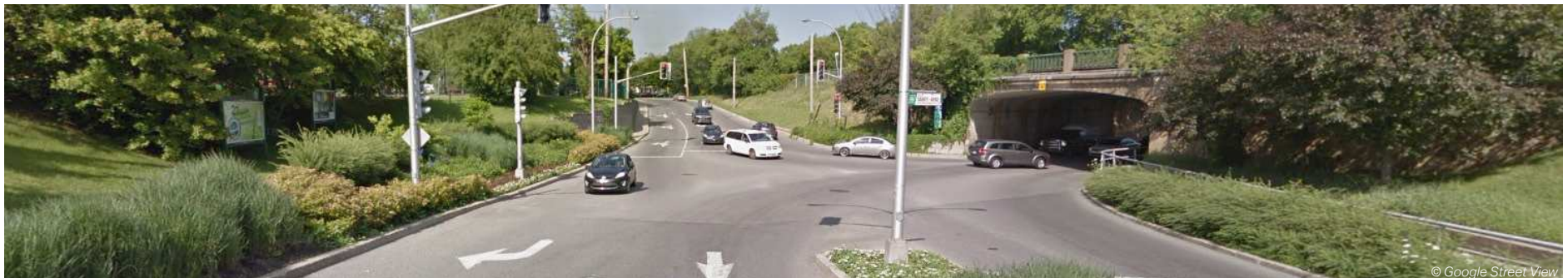
Une des principales entrées au centre-ville : la rue Sicotte et le viaduc de la voie ferrée au-dessus de l'avenue Sainte-Anne.
